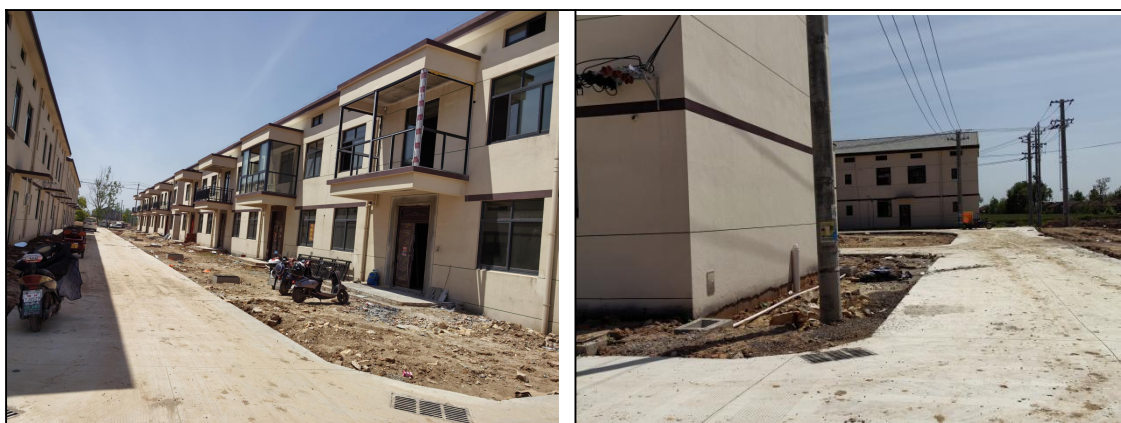
安置房已建成，部分地面未硬化
