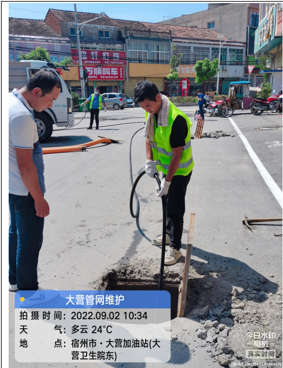
管网日常维护
