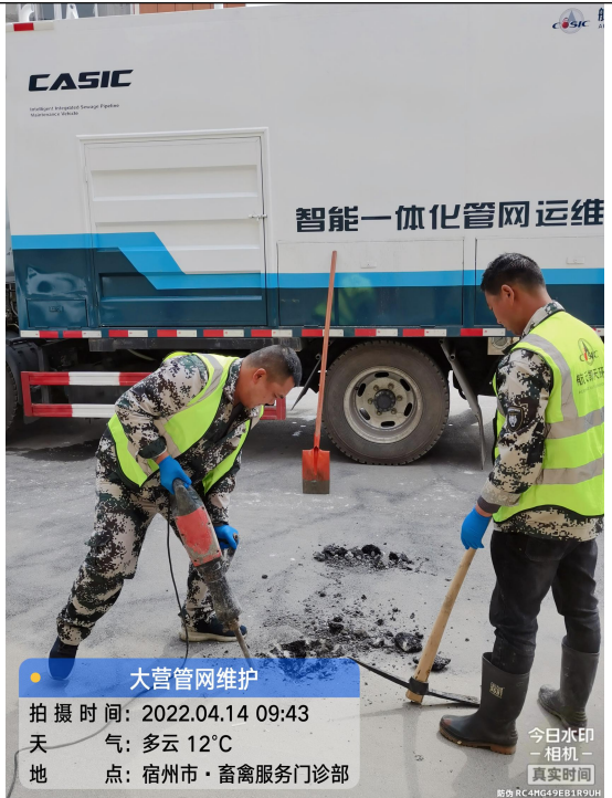
管网日常维护
