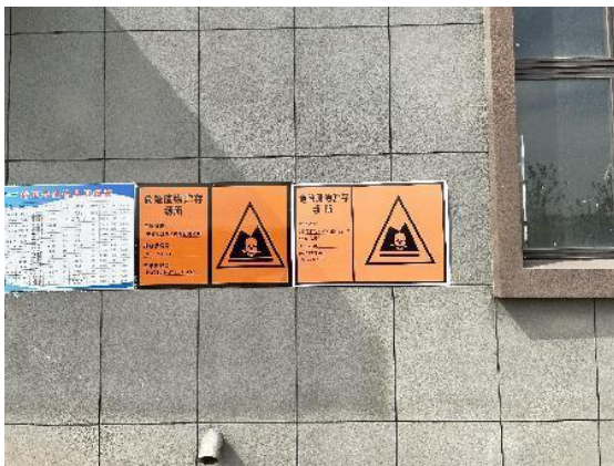
危废库标志牌
