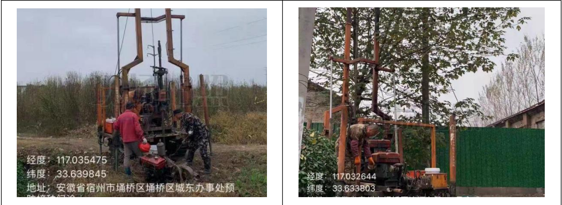
图 5.2-1 现场钻探设备
