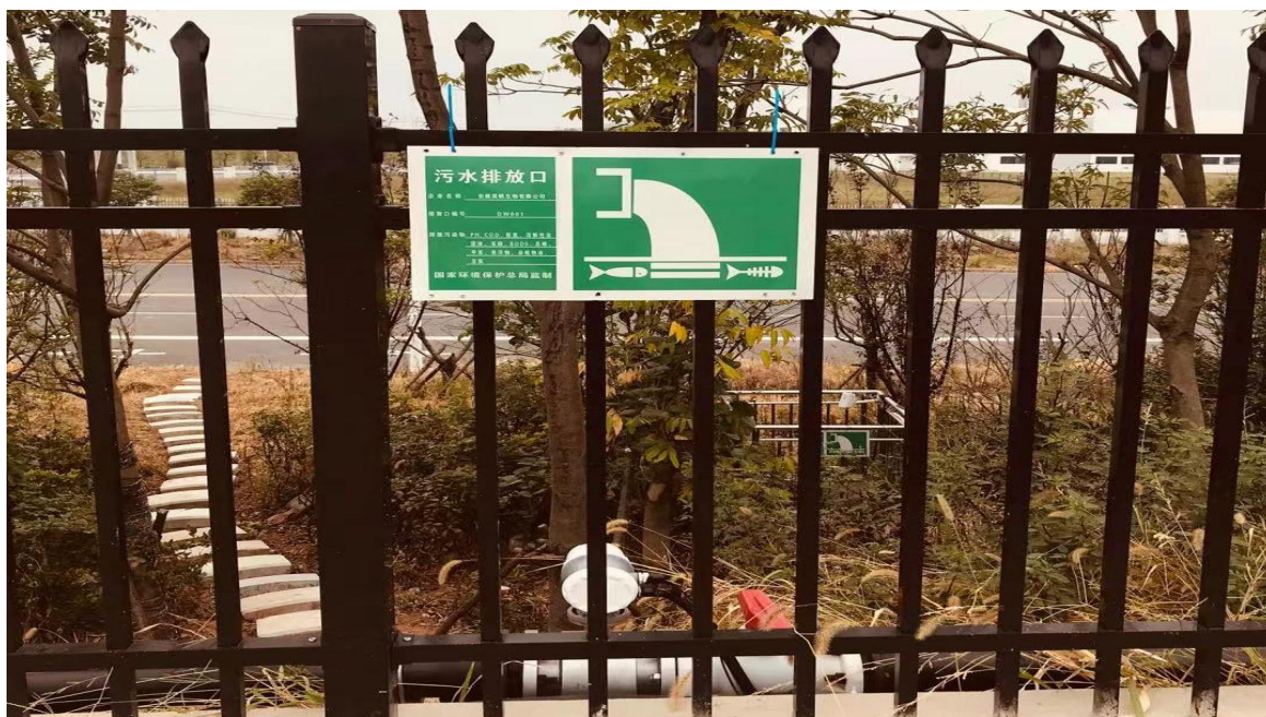
图4.1-4 污水接管口及标识
