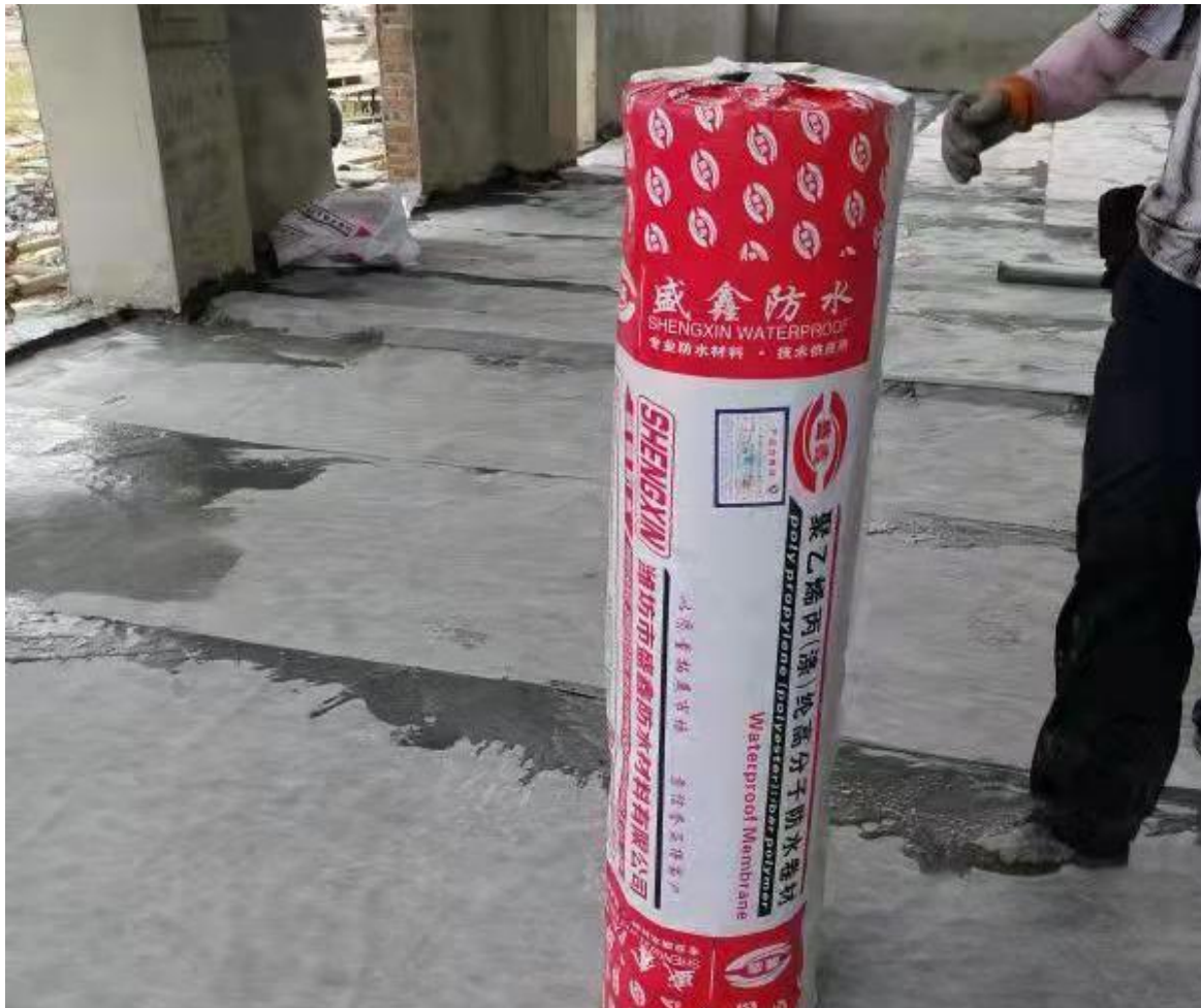
图 4.2-4 施工期防渗材料图
