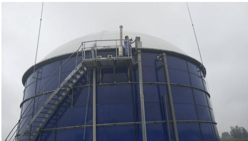
图 3-5 沼气双膜储气袋示意图
