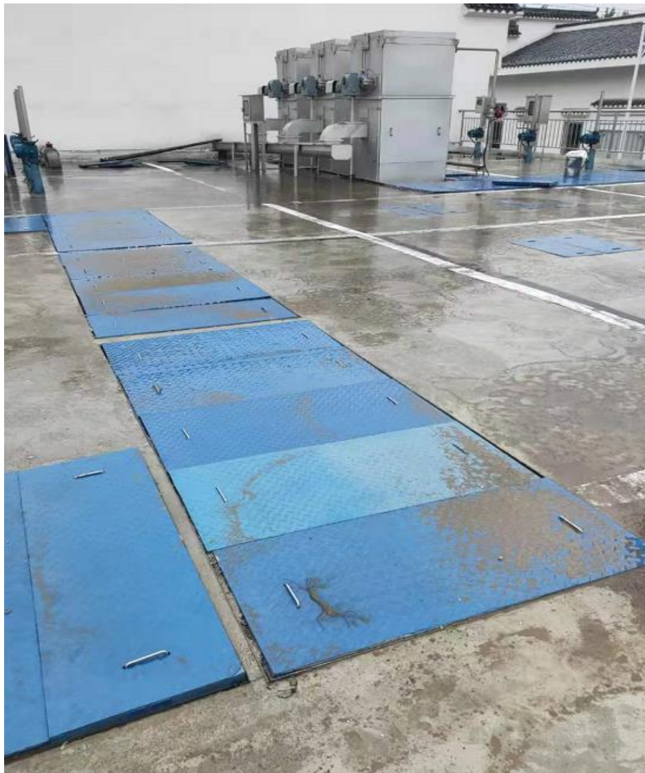
附图四：现场建设情况
