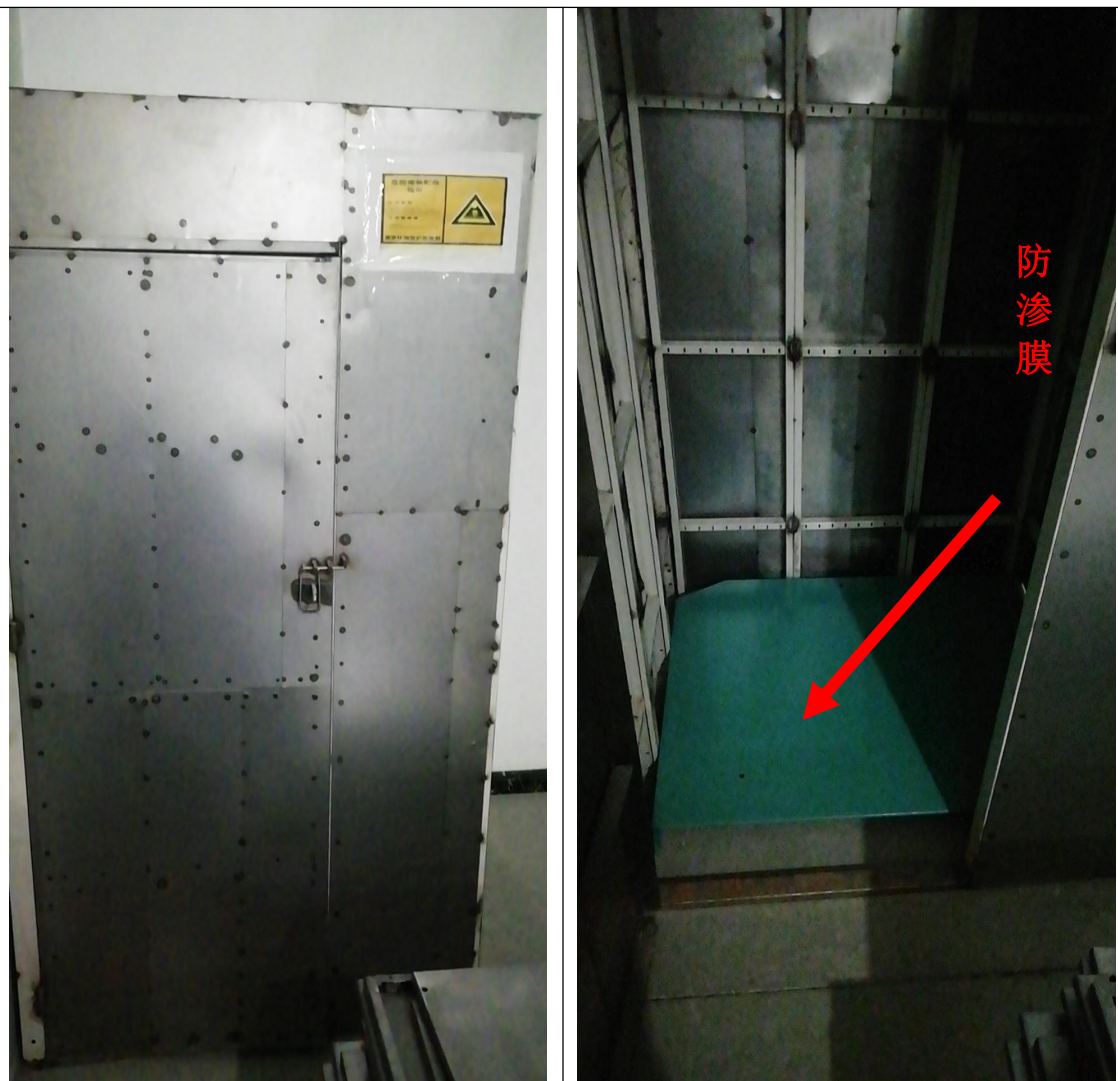
危废库现场图片：
